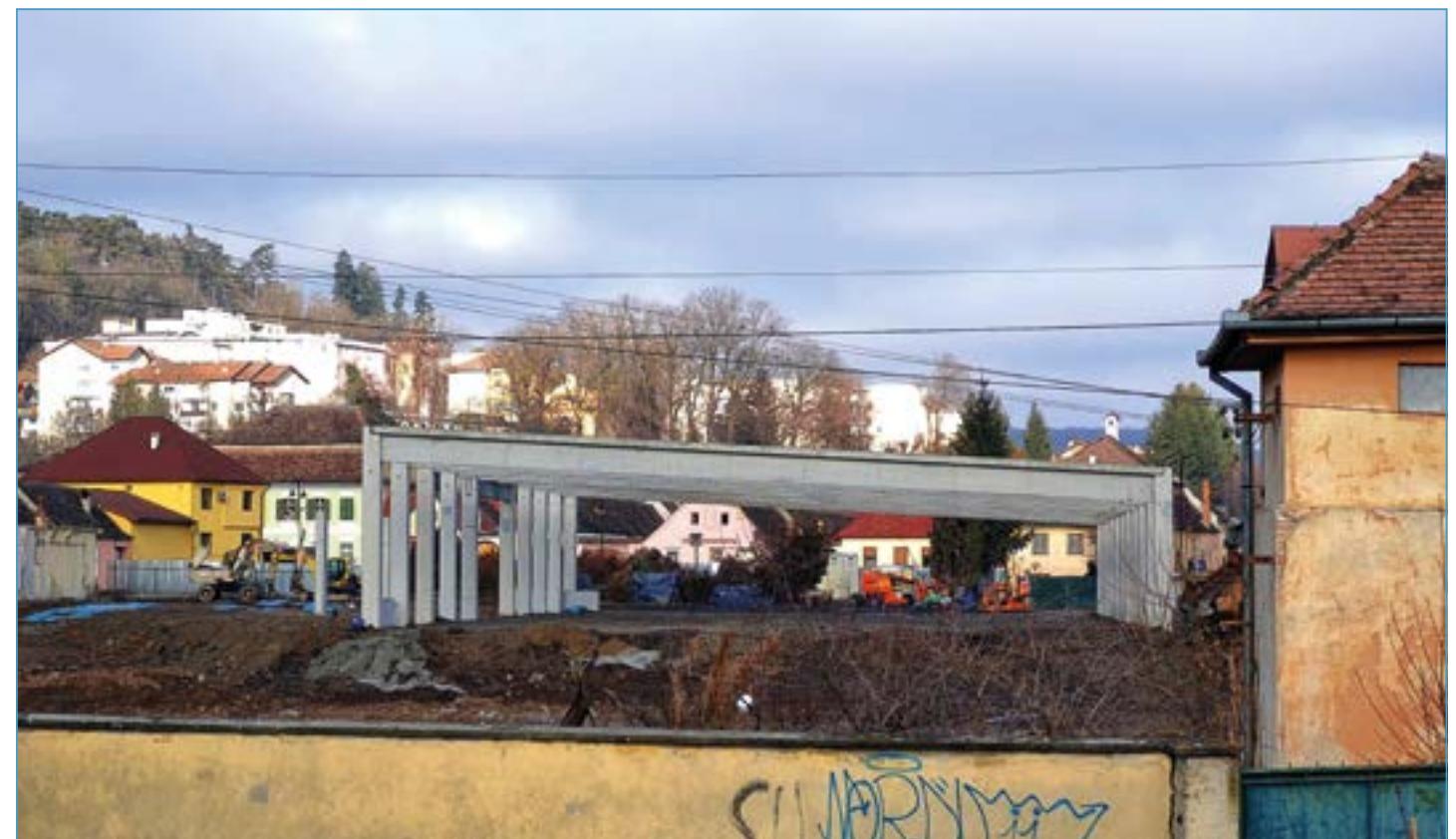
Baustelle auf dem ehemaligen FIPA-Gelände. Hier entsteht ein Lidl-Markt.
